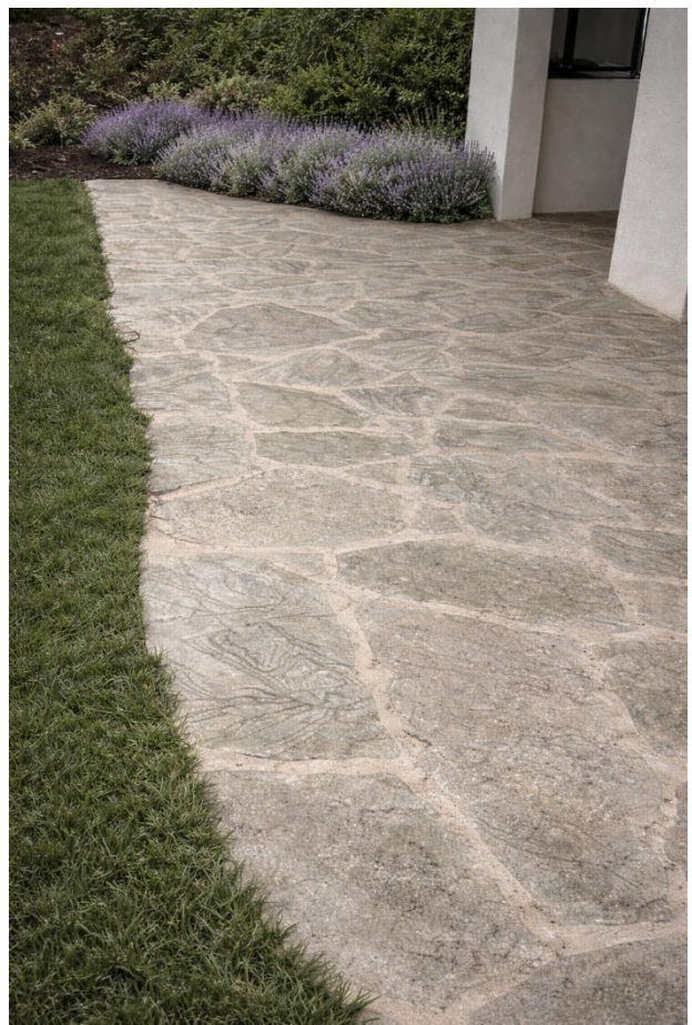
Opus scié & jointé pour réalisation terrasse
